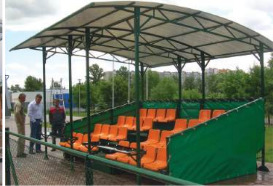
г. Минск Теннисный центр «WIMC»
